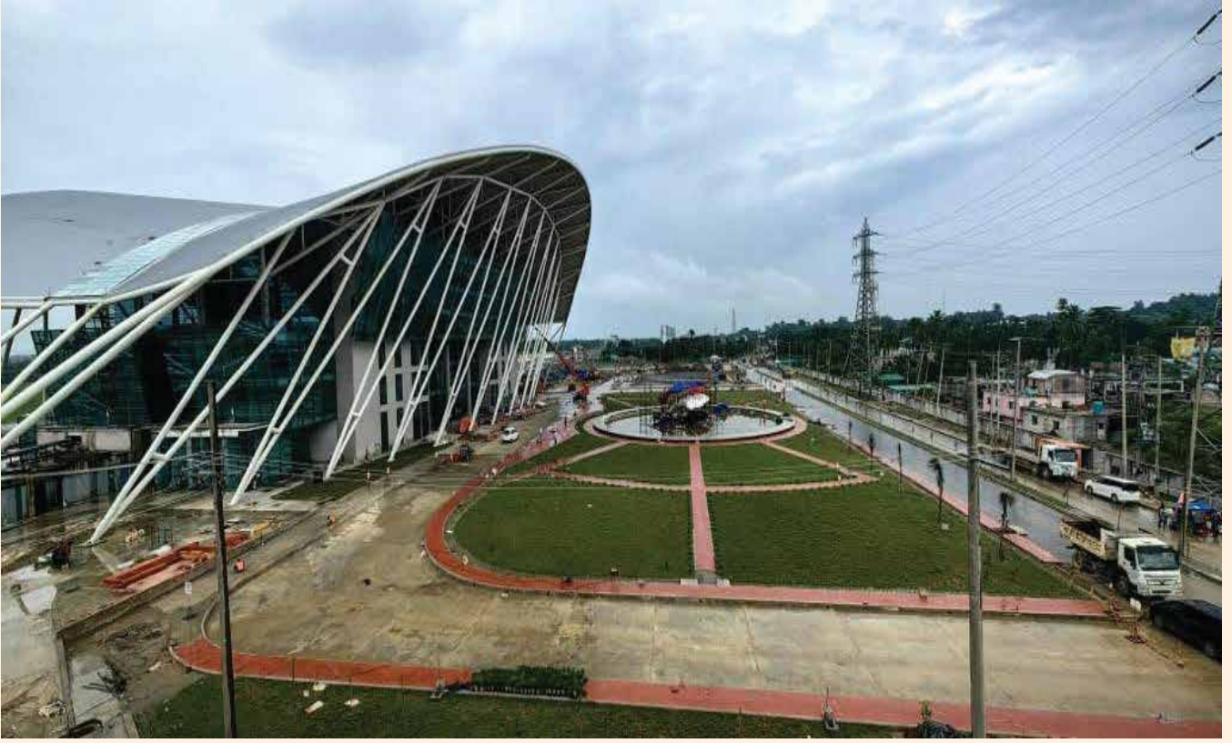
কক্সবাজার-দোহাজারী রেলপথ নির্মাণ প্রকল্পের আওতায় নির্মাণাধীন কক্সবাজার আইকনিক স্টেশন বিল্ডিং।
